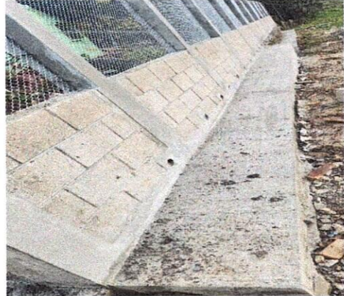
Foto 2: Construcción de una banqueta en el exterior del centro educativo.
