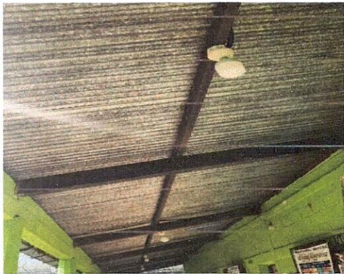
Foto 3: Reparación de instalación eléctrica.
